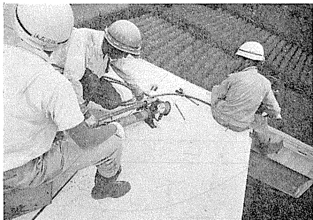
写真-7 上階界壁建込み中
