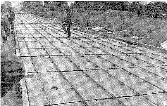
写真-3 打継目部分の構造
