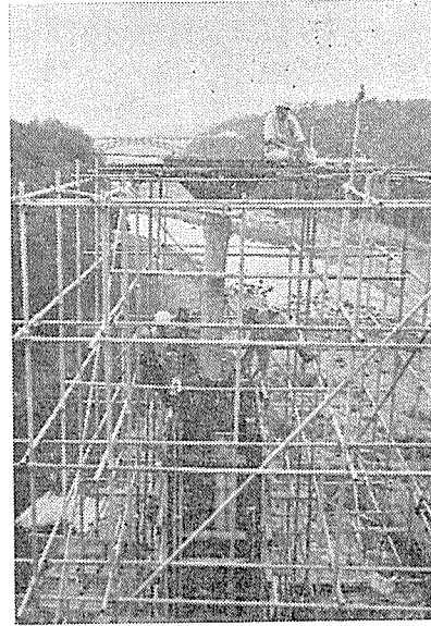
写真-2 橋梁コンクリート打設状況
