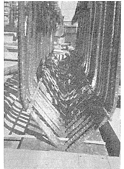
写真-2 鉛シューとメナーゼヒンジ鉄筋
