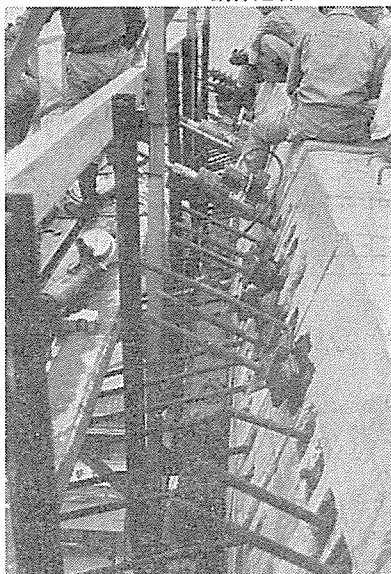
写真-4 Pylon 上ブロックでのつり鋼棒定着
