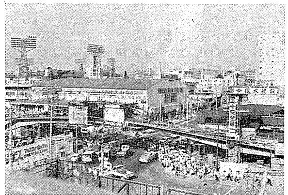
写真-2 工事の後楽園ブリッジ
