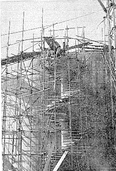
写真-6 回り階段の積み上げ
