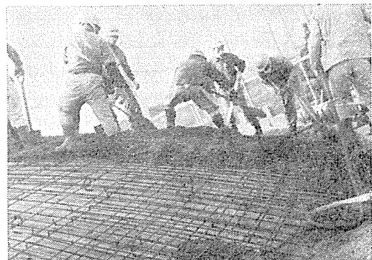
写真-5 ドーム コンクリート打設
