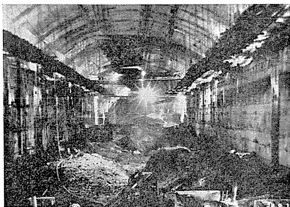
写真-6 城山発電所掘削状況
