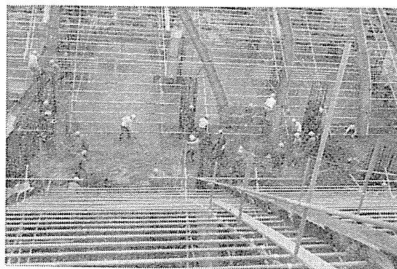
写真-1 底版コンクリート打設作業中
