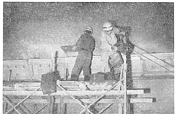
写真-10 受け台取付け、裏込めモルタルでん充
