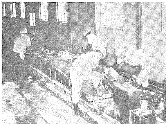
写真-5 天井板製作状況
