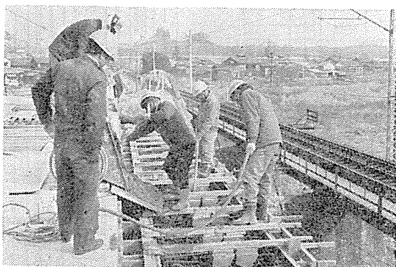
写真-9 上突縁から落とし込まれたコンクリートは、下スラブに待機した、バイブレーターマンによって十分にスラブ隅角部にてん充される。
