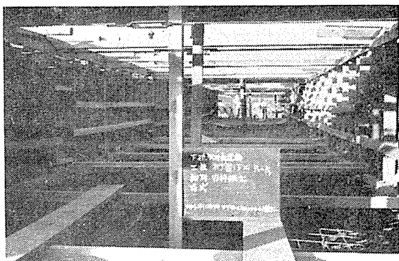
写真一5 主桁内側型わくはくし型 (c.t.c. 30cm) で支持され、これの上下に、橋軸方向に角材を通し内張りとして1.5mおきに9×9cmの角材を用い、同時に、φ13mmのターンバックルでこれを締め付けた。
