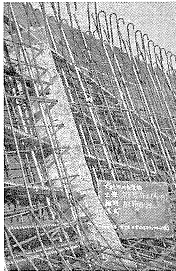
写真-7 桁を3ブロックに分けてコンクリートを打設するために、桁の全断面にわたって、各ブロックの境界面に金網による施工目地を設けた。
