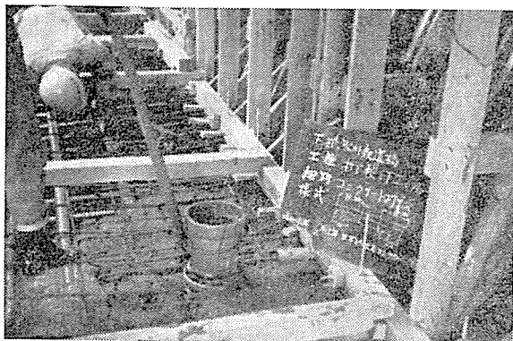
写真-9 上突縁から落とし込まれたコンクリートは、下スラブに待機した、バイブレーターマンによって十分にスラブ隅角部にてん充される。
