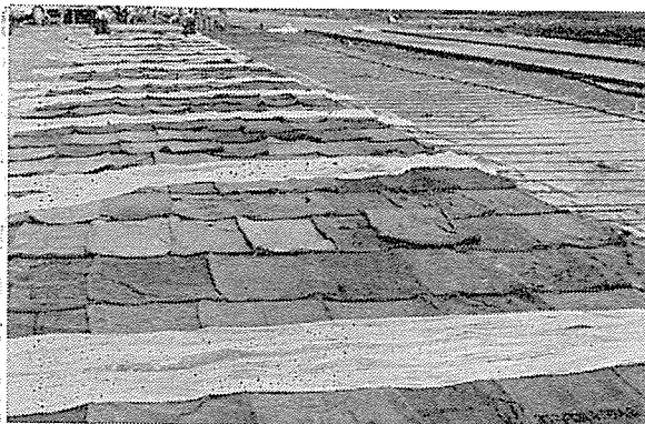
写真-9 養生 (ビニールフィルムの上に麻袋)
