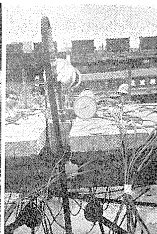
写真-5 フラット ジャッキ 作動中
