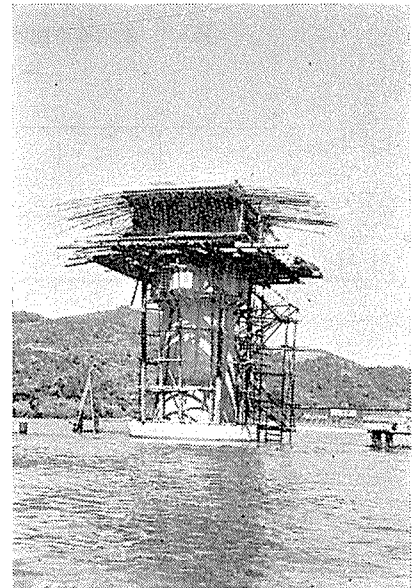
写真—2 柱頭部施工
