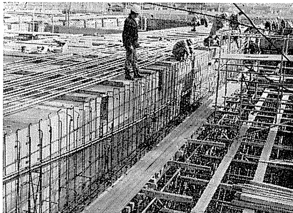
写真-2 完成した PC ラーメン
