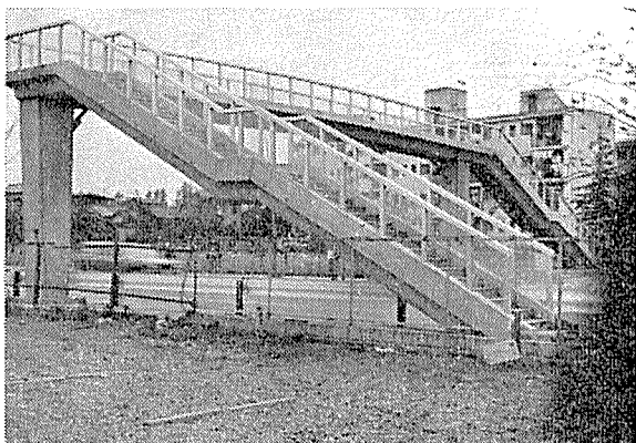
写真-3 完成した横断歩道橋 (L型)
