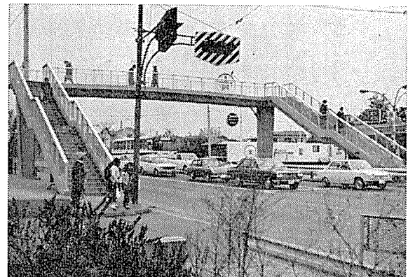
写真一 完成した横断歩道橋（C型）
