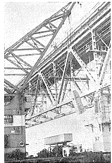
写真-4 大きなコンクリートブロックを起重機船ではつり取った瞬間
