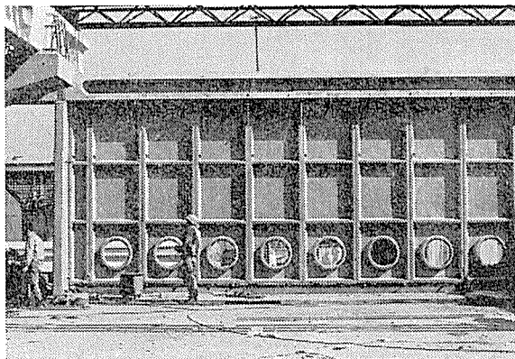
写真-6 外壁 PC版の建込
