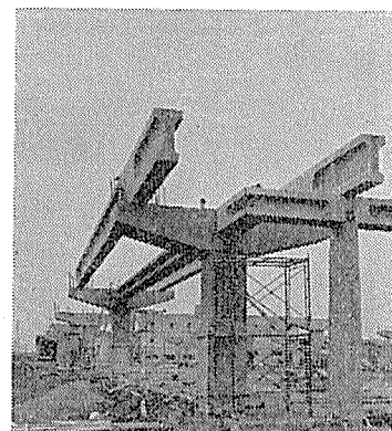
写真-2 PC桁のセット状況
