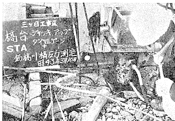
写真-4 橋台ダイヤルゲージ設置
