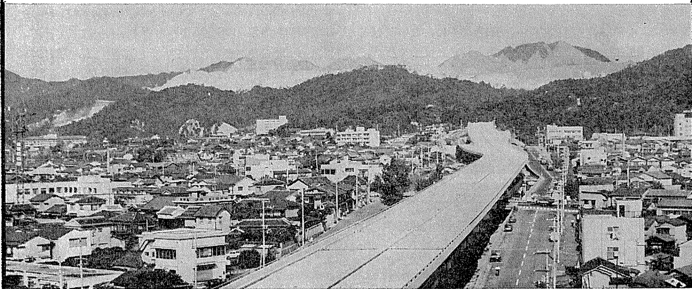
阪神高速道路月見山第1工区高架橋
