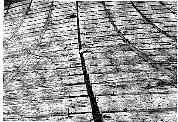
写真-3 目地コンクリートと抜目地部分
