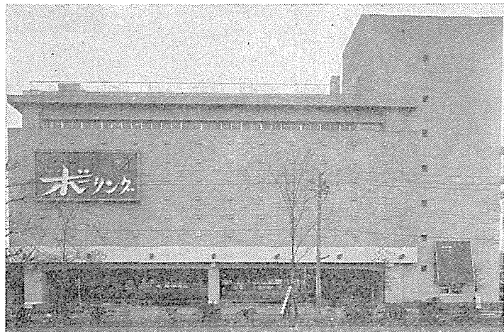
写真-5 完成写真
