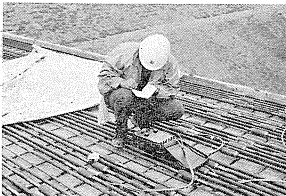
写真-3 鋼棒応力度の測定
