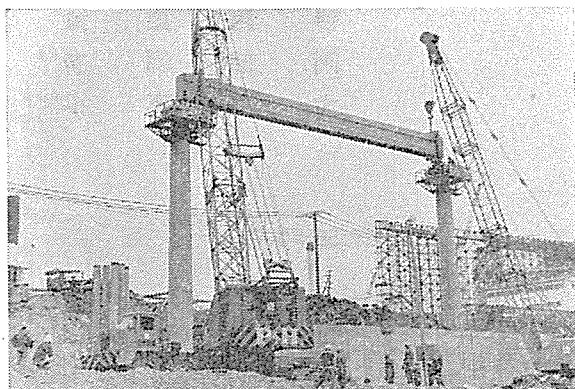
写真-8 軌道桁の架設状況
