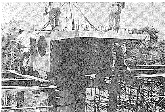
写真-5 主桁の基準ブロックの架設
