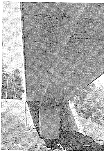
写真-9 完成後下からみた主桁
