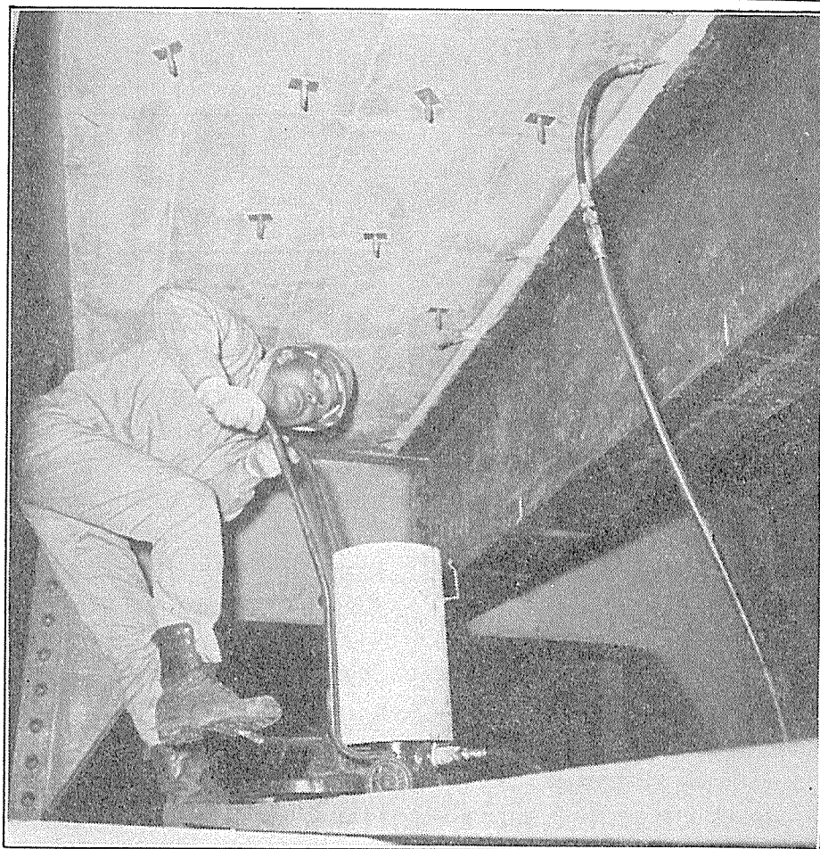
(ストリンガー増設工法による橋梁床版補強工事)
