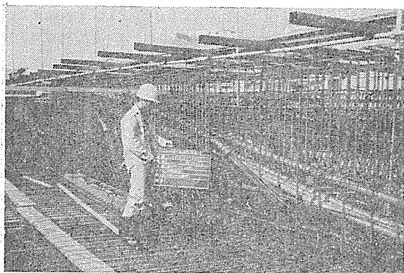
図-20 主桁ケーブル配置
