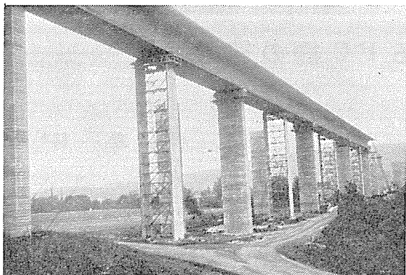
写真-1 Taubertal Brücke の現場
