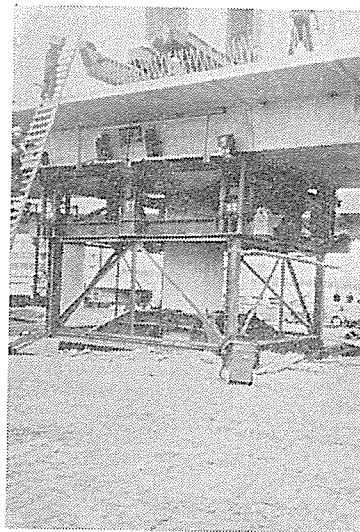
写真-5 Kleinpolder Plein のトラス支点部支保工
