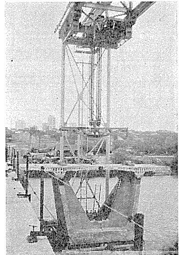
写真-9 Blois 橋の桁断面
