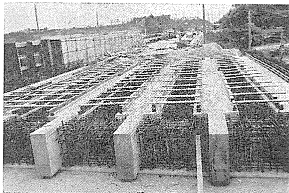
写真-3 杭ばり上にプレキャストのPC桁を配置したところ(第3次施工中)
