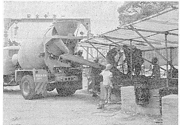
十字ばり製作は門型クレーンレール内で実施した。脱型は屋根のシートをはずして行なう。
