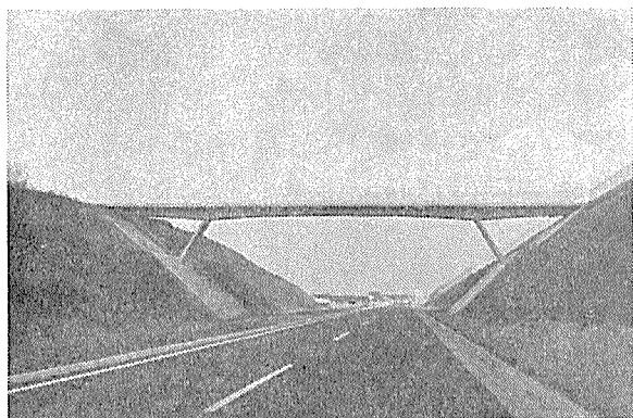
写真-10 完成した牧道架道橋
