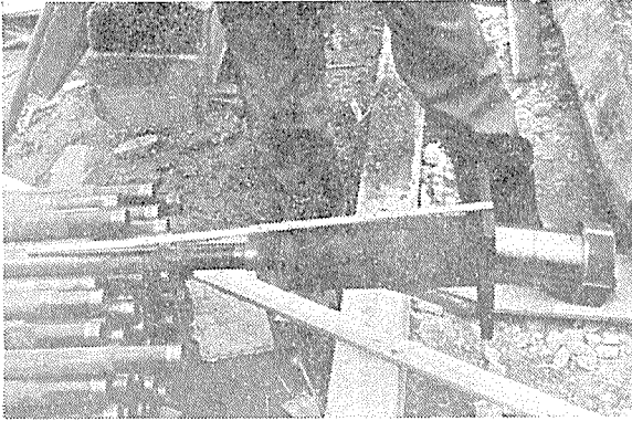
写真-14 ストランドのケーブル製作
