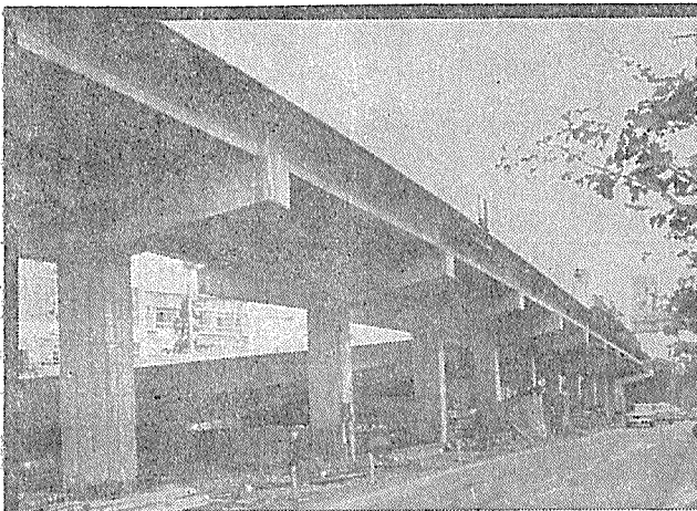
首都高速度道路高架橋
