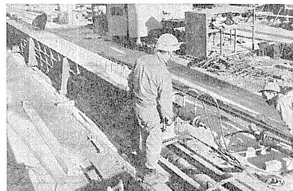
写真-3 大ばり鋼棒緊張作業
