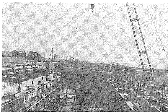
写真-8 B 工区大ばり架設
