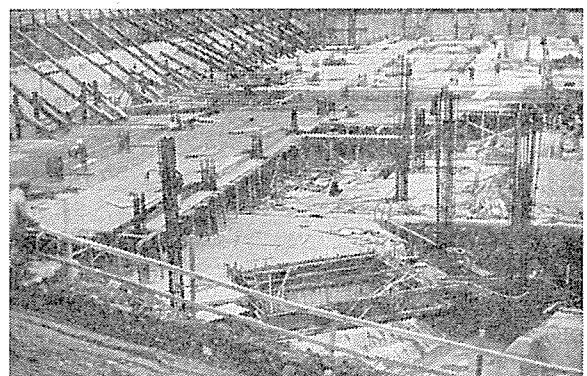
写真-15 建設中の FBI ビル
