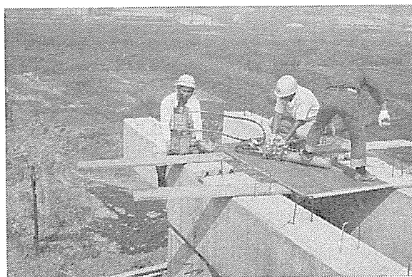
写真-7 D.T.W 架設中
