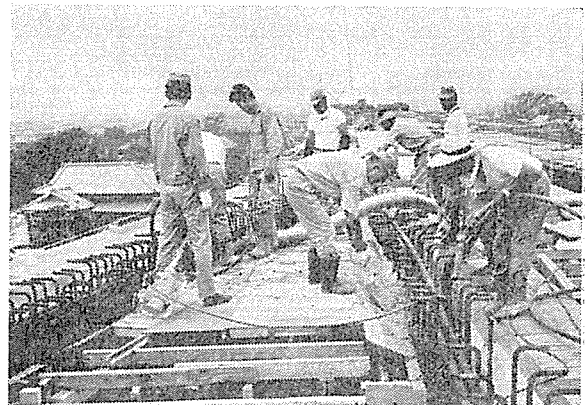
写真-4 腹板(拡幅部)コンクリート打設状況
