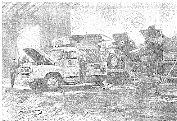
写真-2 コンクリート圧送中のポンプ車
