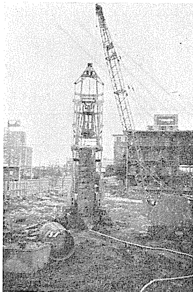
写真-3 50 TH によるアースドリル工事
