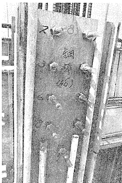
写真-13 柱型わくと PC 鋼棒
