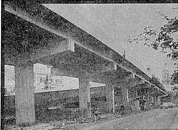
首都高速度道路高架橋
