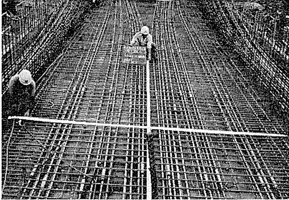
写真—10 側径間鋼棒組立て
