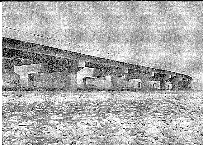
建設省 西湘バイパス道路
