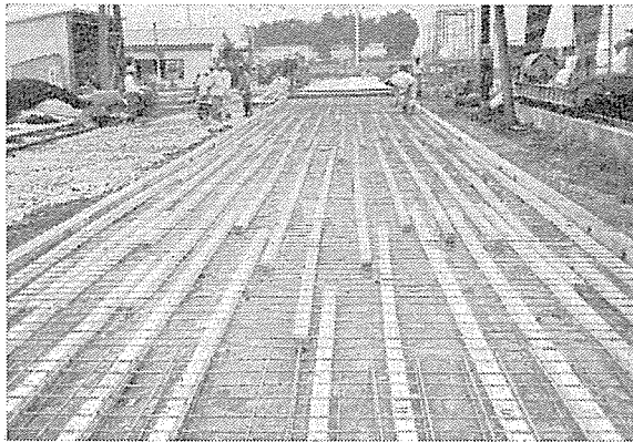
写真-3 PC ロッド組立て完了 (ロッドのラップ長は 1.3m)
