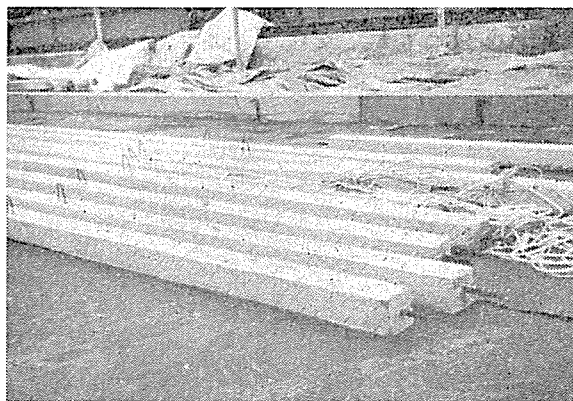
写真-2 路盤線に建築用ルーフィングペーパー (型わくは 15 cm × 15 cm の木製型わくを鉄製ピンで固定)
