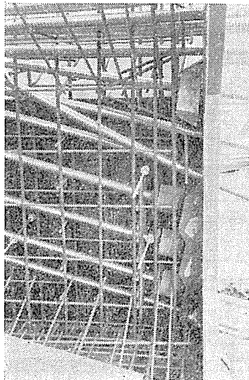
写真-3 ブロック端部の配筋
