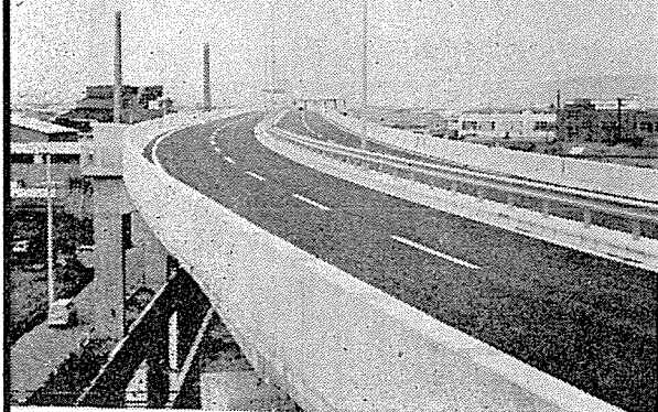
阪神高速道路 / 守口高架橋
