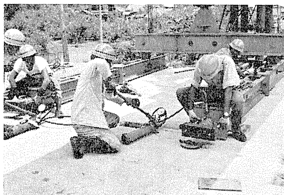
写真一八 ブロックの引寄せ仮定着
