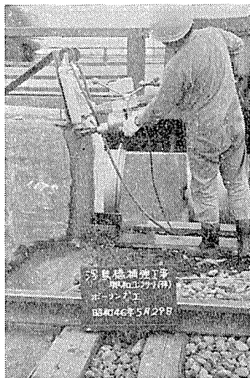
写真-5 主桁せん孔工
