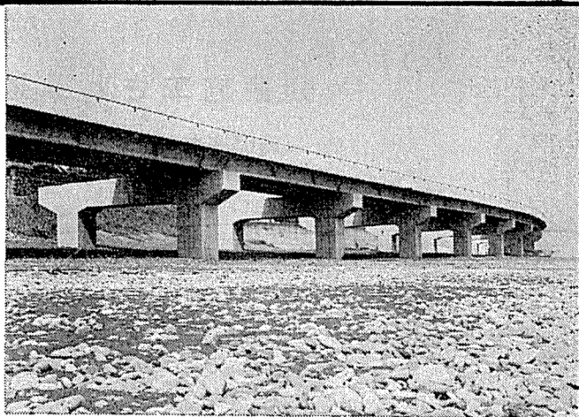
建設省 西湘バイパス道路
