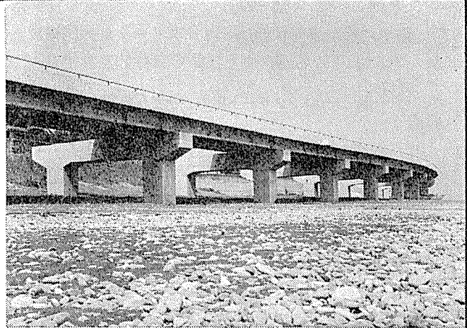
建設省 西湘バイパス道路
