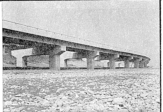
建設省 西湘バイパス道路
