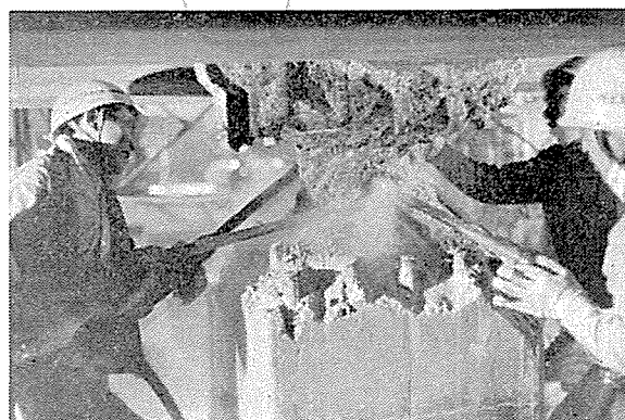
写真-4 柱切断
