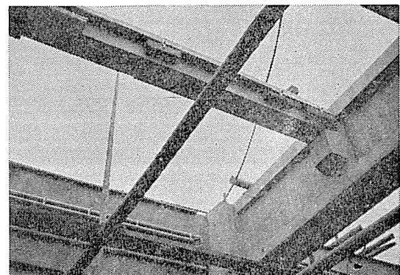
写真-10 スラブ型わく段取り
