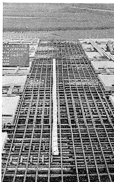
写真-10 連結部床版配筋
